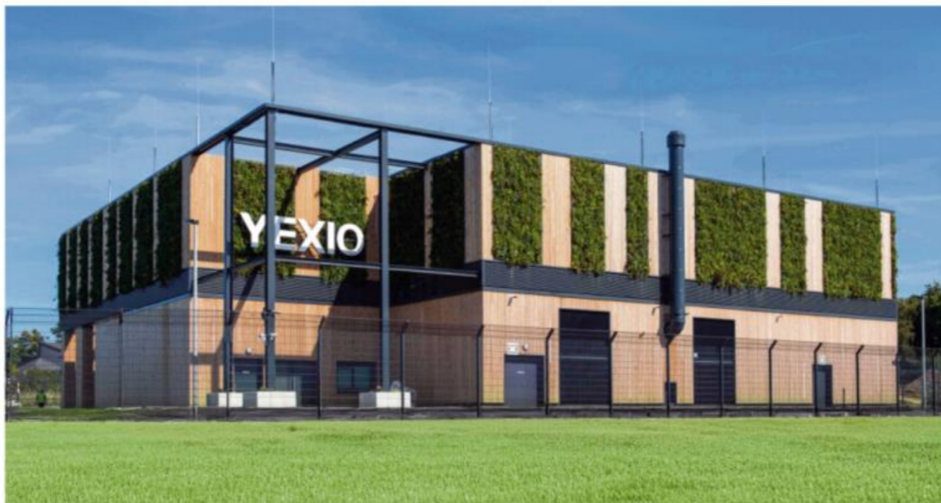
Hochtief profitiert vom wachsenden Markt mit Rechenzentren – so wie hier beim Bau des Yexio-Rechenzentrums in Heiligenhaus bei Essen. Quelle: Hochtief
