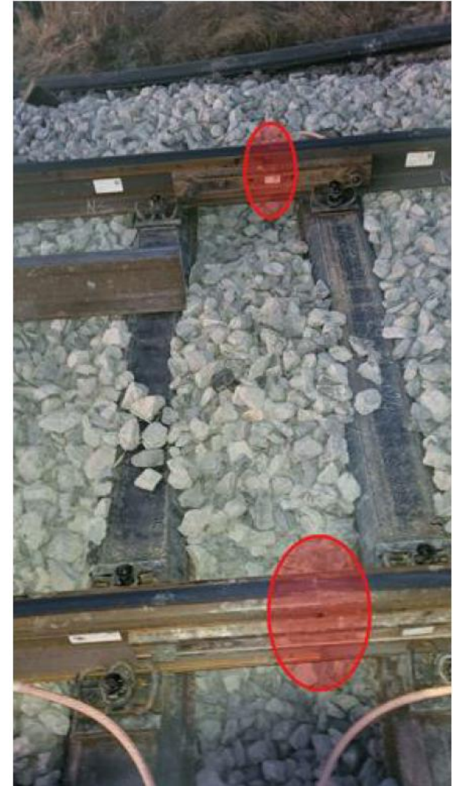
Verlaschte Schienenenden, die Stosslücken sind komplett geschlossen
